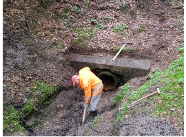
Sanierung des Entwässerungsdurchlass in Km 18,3 im Edenbachtal mit Transportbahn
