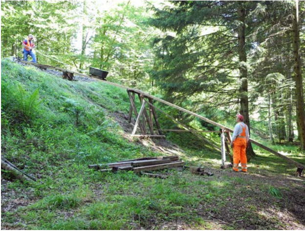
Sanierung des Entwässerungsdurchlass in Km 18,3 im Edenbachtal mit Transportbahn
